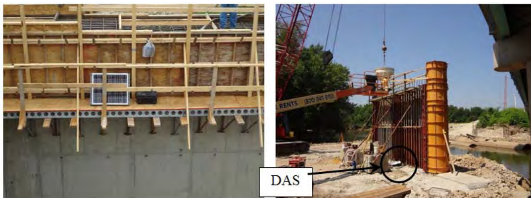
b) Bent 2 Pier Cap
