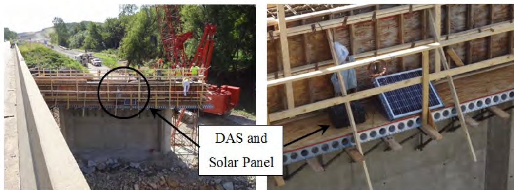
a) Bent 3 Pier Cap
